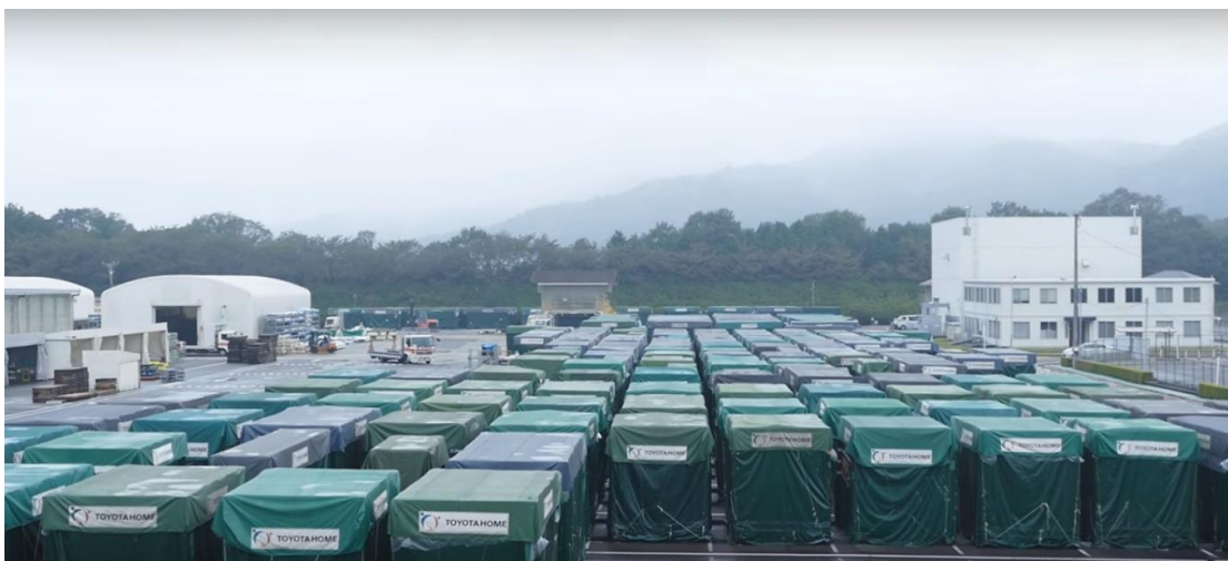
Figura 31 Módulos listos para ser transportados al lugar de montaje (Jun, 2016)
