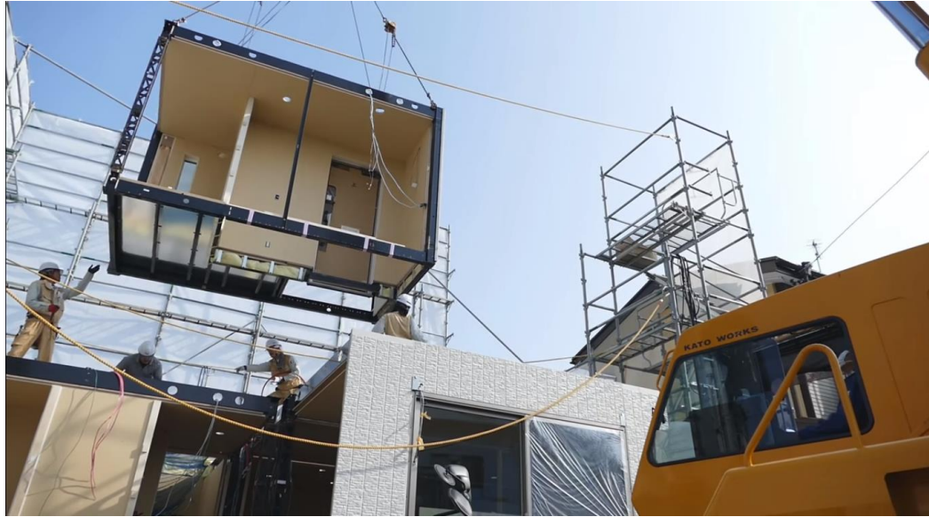
Figura 32 Montaje de módulos (Jun, 2016)
