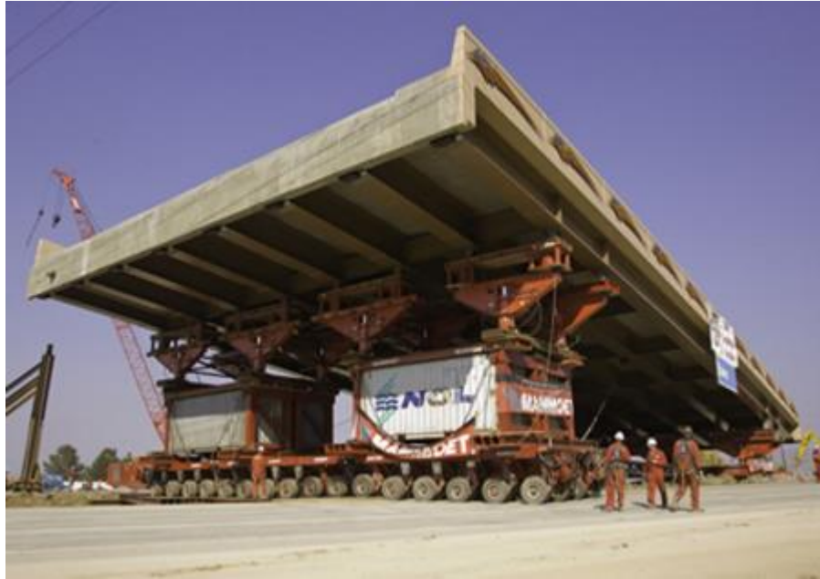
Figura 30 Uso de transportador modular para instalación de puentes (Transportation, 2010)
