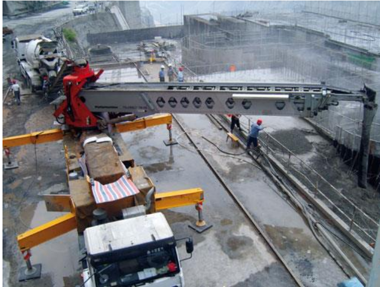
Figura 29 Telebelt en la construcción de una presa (Putzmeister, 2017)
