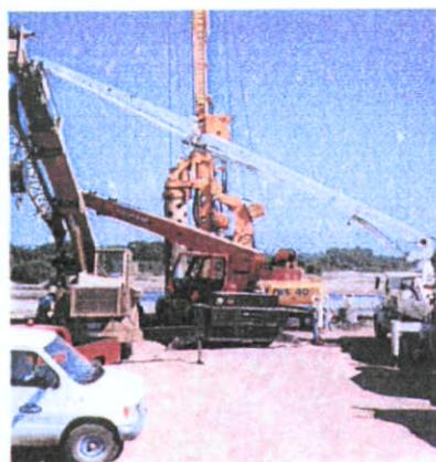
Fig. 5.5.-Equipo utilizado en el proceso del cilindro piloteadora, Grúas de montaje
