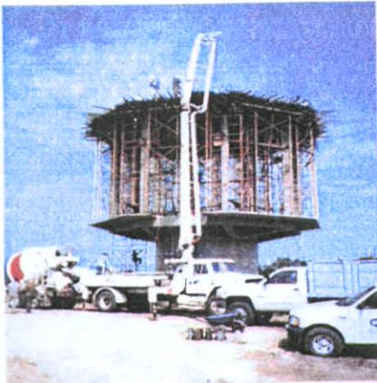
Fig. 5.13.- Proceso de cimbrado para colar techo caseta de operación de bombas
