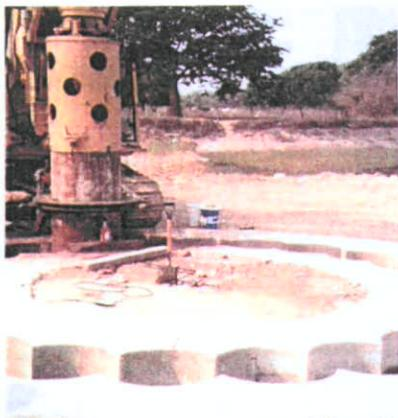
Fig. 5.3.- Plantilla para hincado de pilotes de concreto armado en la formación del cilindro
