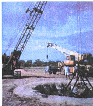
Fig. 5.6.- Cucharón de almeja para la excavación del cilindro previa al colado del tapón de fondo
