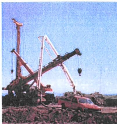
Fig. 5.4.- Colado de pilotes con bomba
