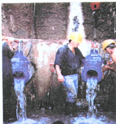
Fig. 5.10.- Compuertas de control individual para la extracción del acuífero, conectadas a drenes
