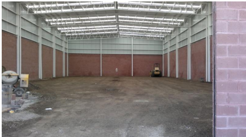
Trabajos de compactación 1
