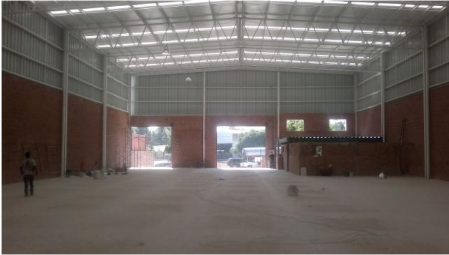
Vista del interior con concreto 1
