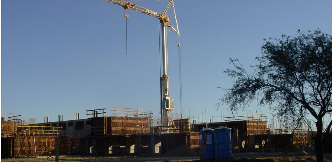
Fotos No. 2 y 3. Casas en proceso con el sistema Outinord©.
