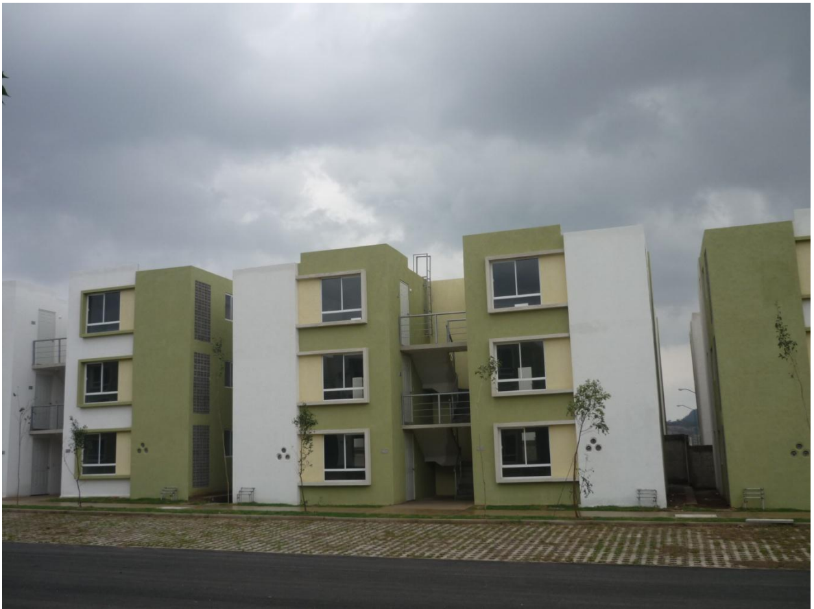
Vivienda para Trabajadores de 2.6 SMM en Zapopan, Jalisco.
