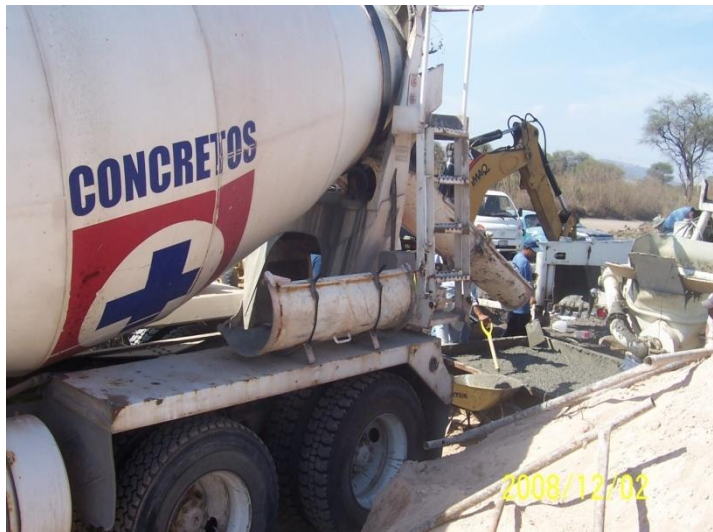
Fig. 3.6 “Cubicación” de concreto bombeable. La retroexcavadora traslada el material desde la artesa a la tolva de la bomba.
