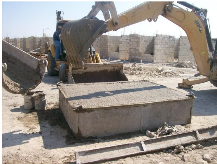
Fig. 3.4 Entrega del material “cubicado” utilizando retroexcavadoras.
