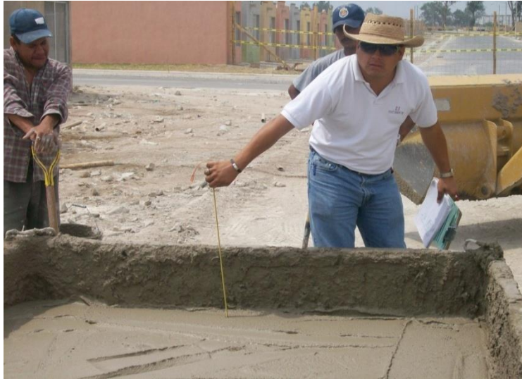
Fig. 3.5 Cálculo del volumen total entregado por el camión.
