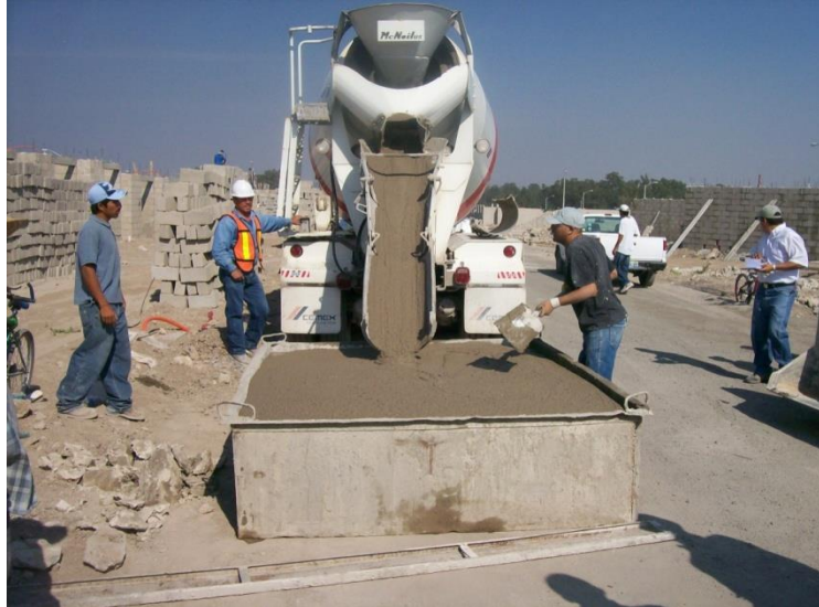
Fig. 3.1 “Cubicando” un camión con mortero.
