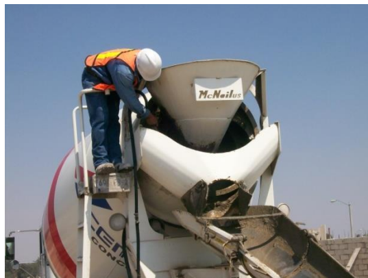
Fig. 4.1 Algún camión cargado excediendo su capacidad pudiera derramar material.
