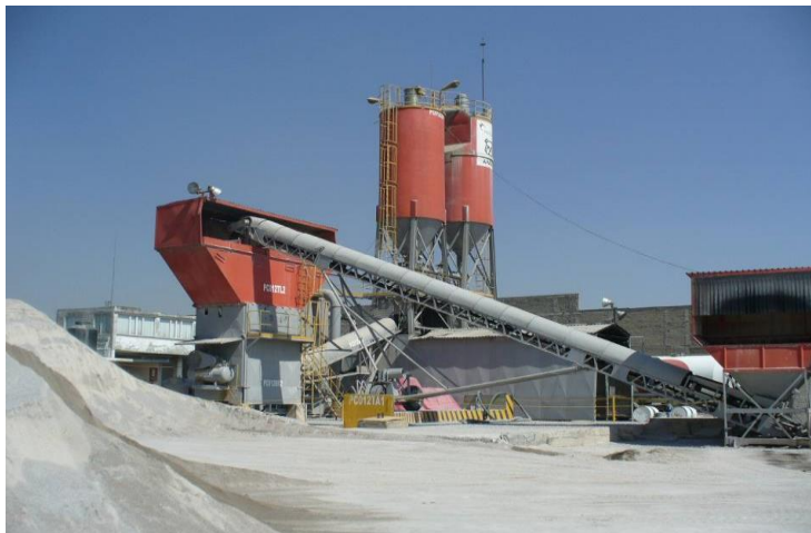
Fig. 2.3 Elaboración de concreto en plantas especializadas.
