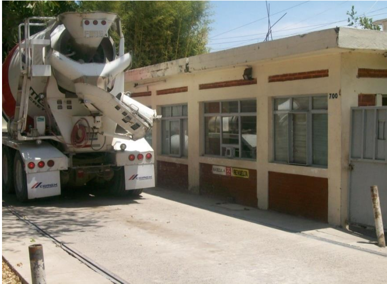
Fig. 3.2 Camión cargado con concreto, pesándose en la báscula comercial antes de llegar a la obra.
