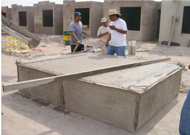
Fig. 3.3 Artesa metálica utilizada para la “cubicación” de camiones.
